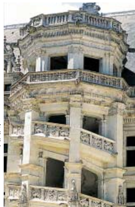
Blois : empruntez l'escalier à double révolutions où deux personnes peuvent descendre et monter sans jamais se croiser.
